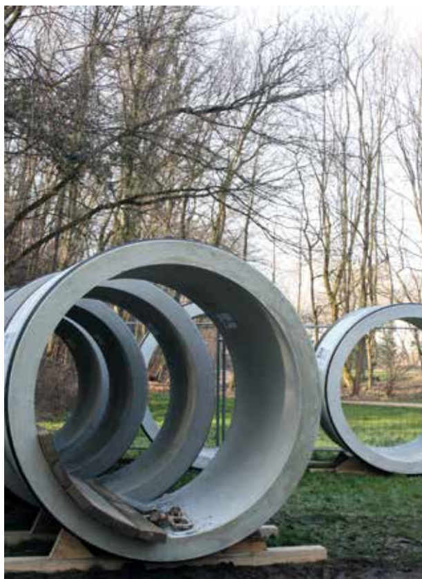
Chantier du collecteur de l'Yzeron.
