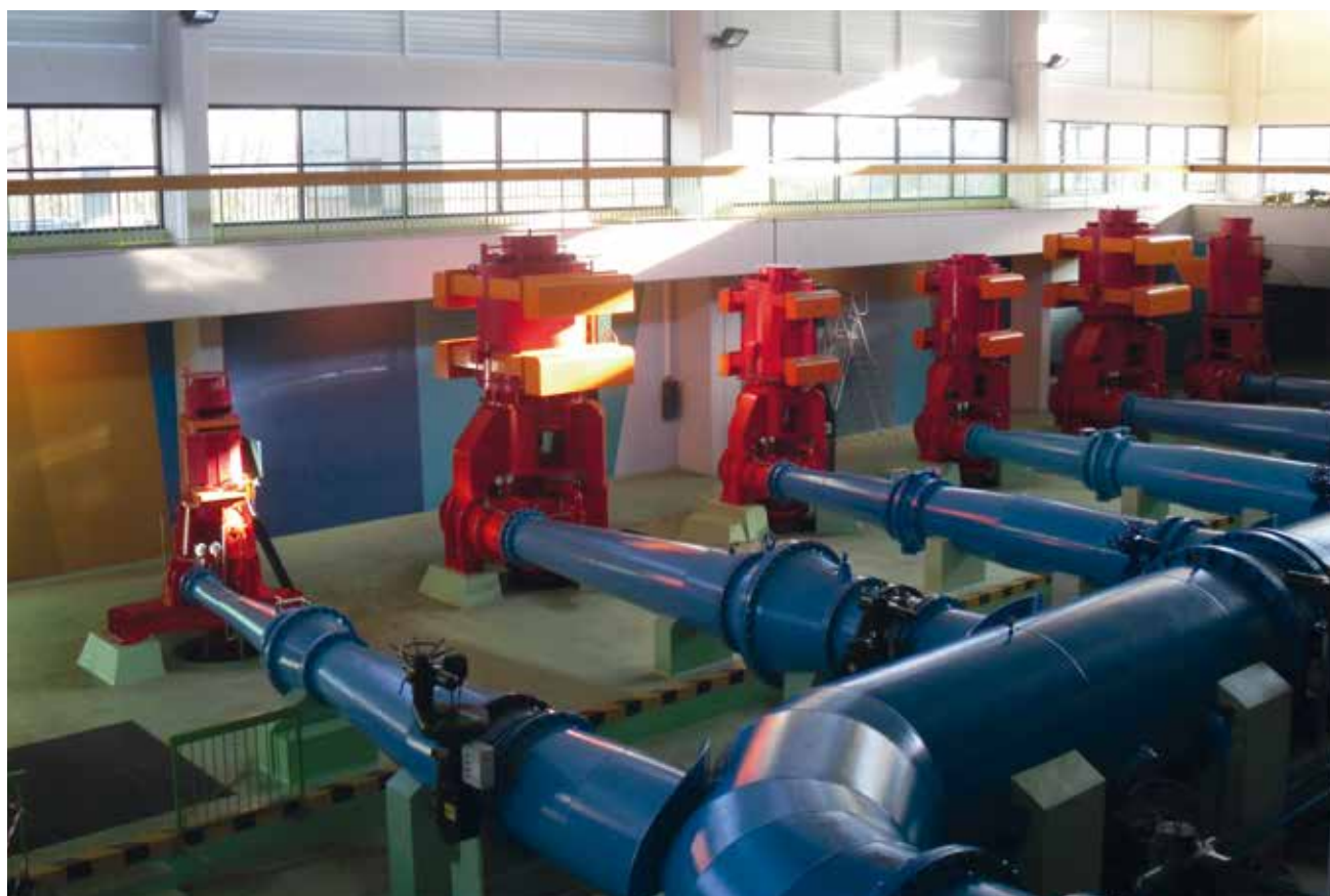
Usine des eaux de Croix-Luizet (Villeurbanne).
