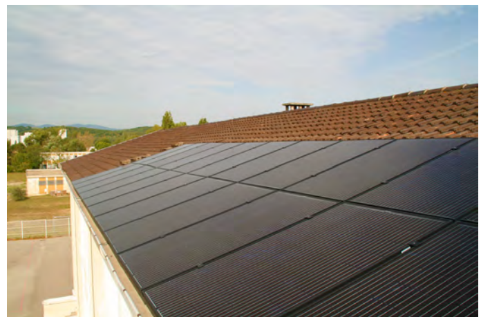
Toit photovoltaïque de l'école Pasteur à Grigny
