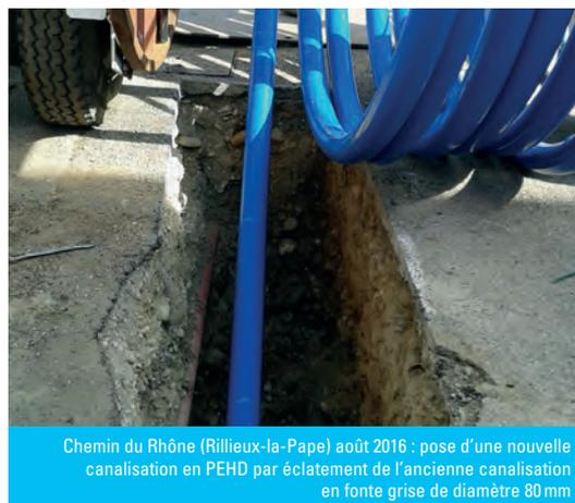
Chemin du Rhône (Rillieux-la-Pape) août 2016 : pose d'une nouvelle canalisation en PEHD par éclatement de l'ancienne canalisation en fonte grise de diamètre 80 mm
