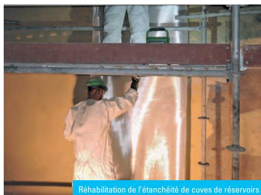
Réhabilitation de l'étanchéité de cuves de réservoirs
