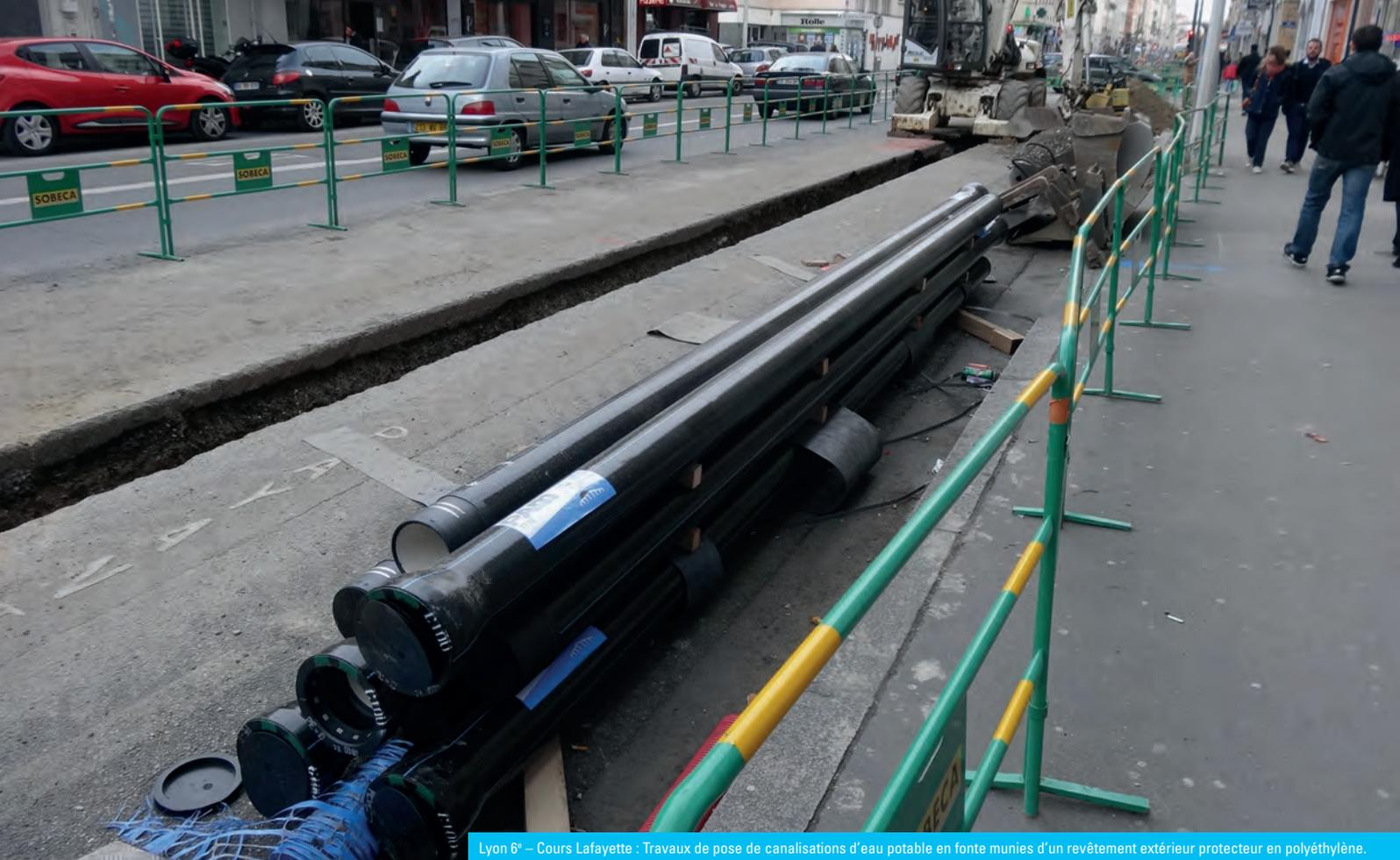
Lyon 6<sup>e</sup> – Cours Lafayette : Travaux de pose de canalisations d'eau potable en fonte munies d'un revêtement extérieur protecteur en polyéthylène.
