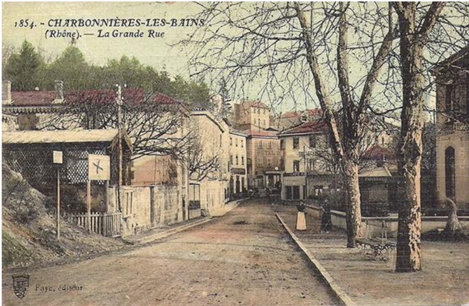
Grande rue des Eaux au niveau de la place Marsonnat
