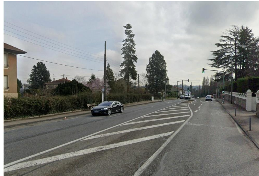
Aménagement existant Route de Paris (Secteur 4)
